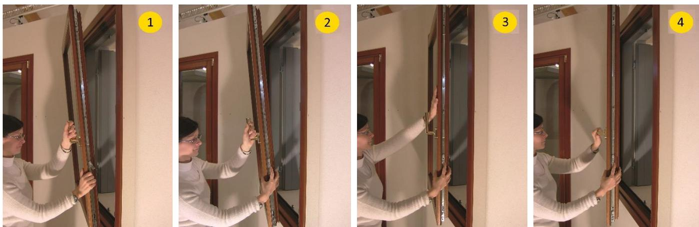
A questo punto ruotare la martellina a 90° in posizione di apertura normale come nella foto 4 e rilasciare il dispositivo di falsa manovra; la cerniera superiore rimarrà perfettamente trattenuta nella sua sede e si potrà utilizzare normalmente la finestra.
